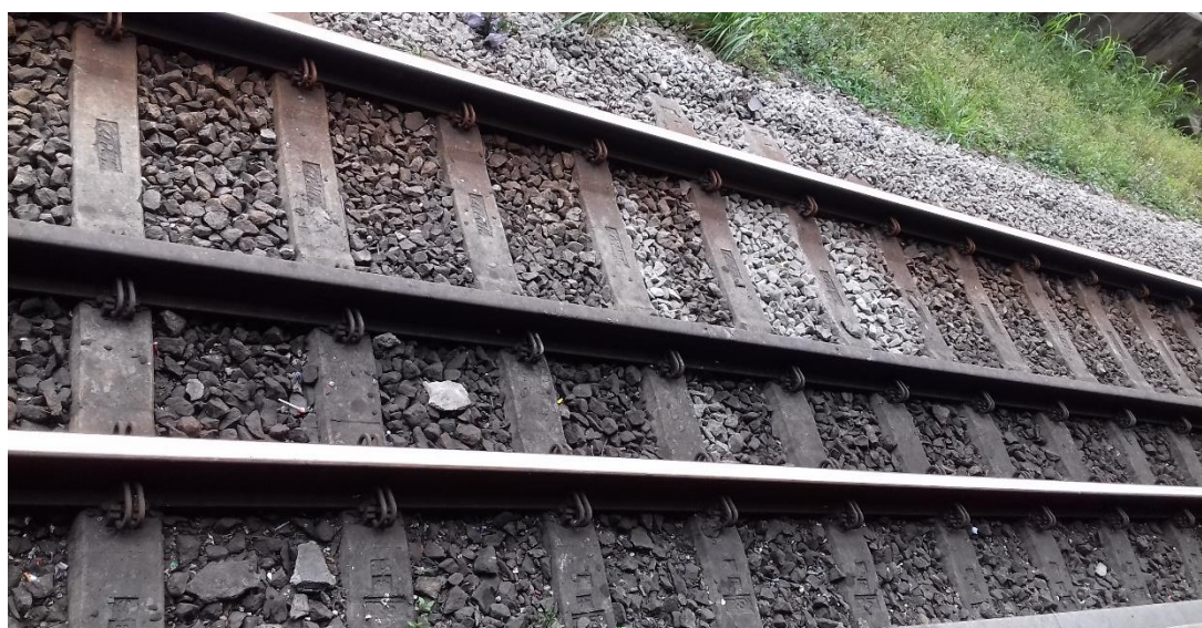
Figura 12 - Bitolas métricas e irlandesas na mesma via permanente. Linha Esmeralda, terminal Pinheiros.
