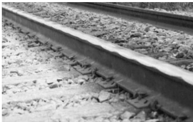
Figura 24 - Desgaste ondulatório (GRASSIE, 2009)
