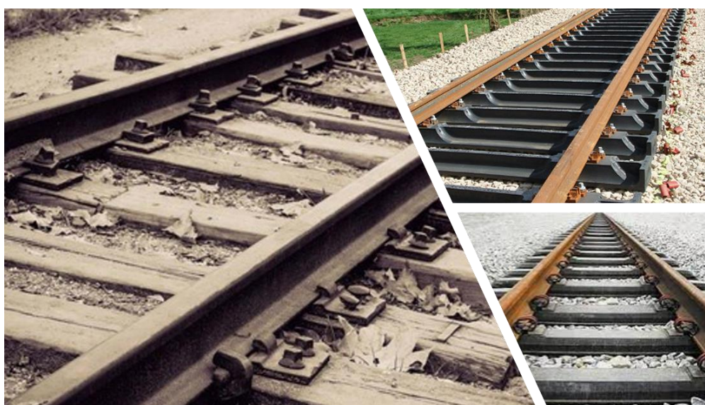
Figura 5 - Dormente de: madeira (esquerda), aço (cima) e concreto (baixo). (Observatório Metro Ferroviário, UFSC)
